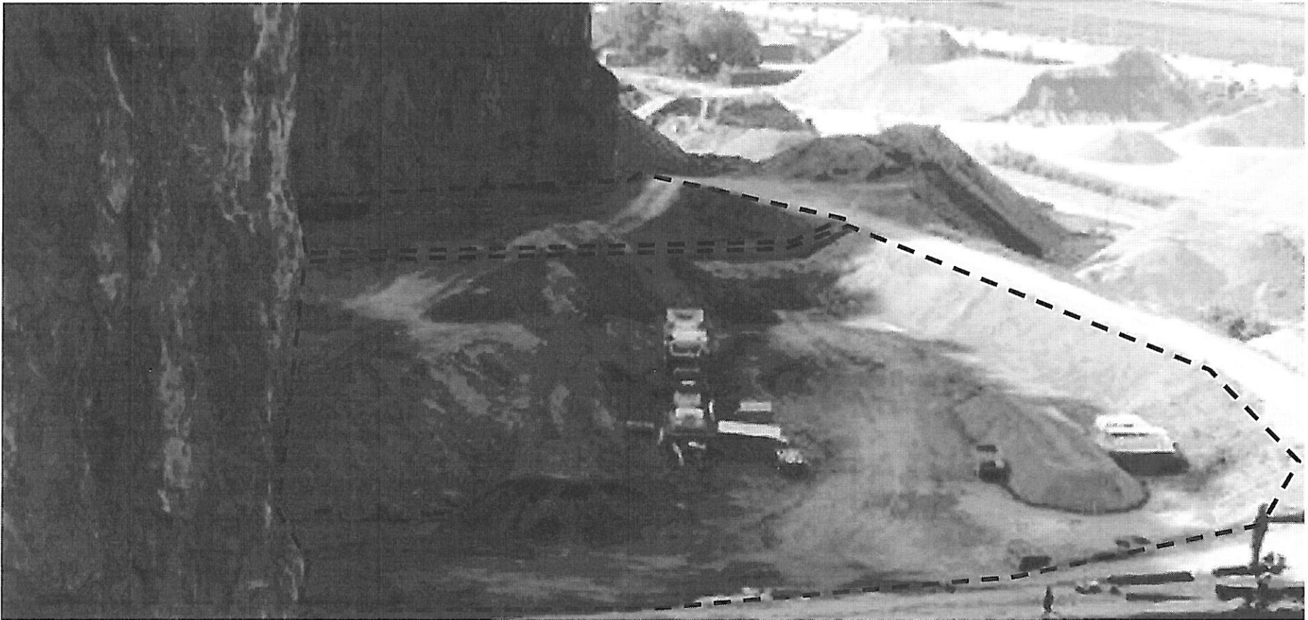
Casier à scories et casier à bitumes en début d'exploitation
